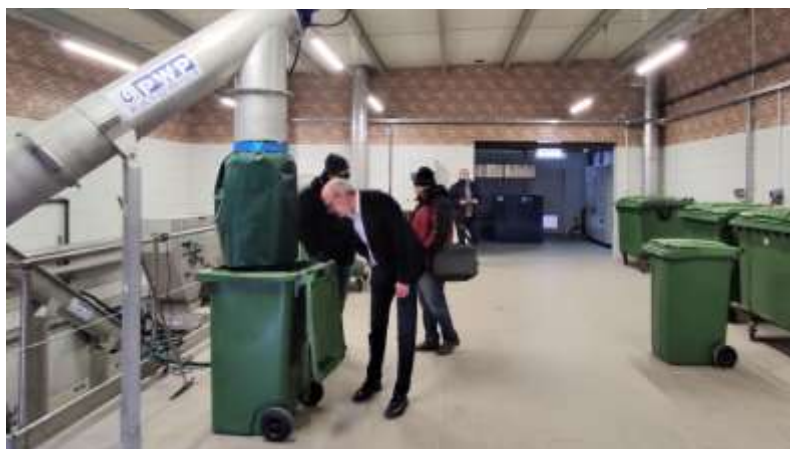
Fot. 2 Wnętrze oczyszczalni Ścieków Komunalnych w Moryniu
