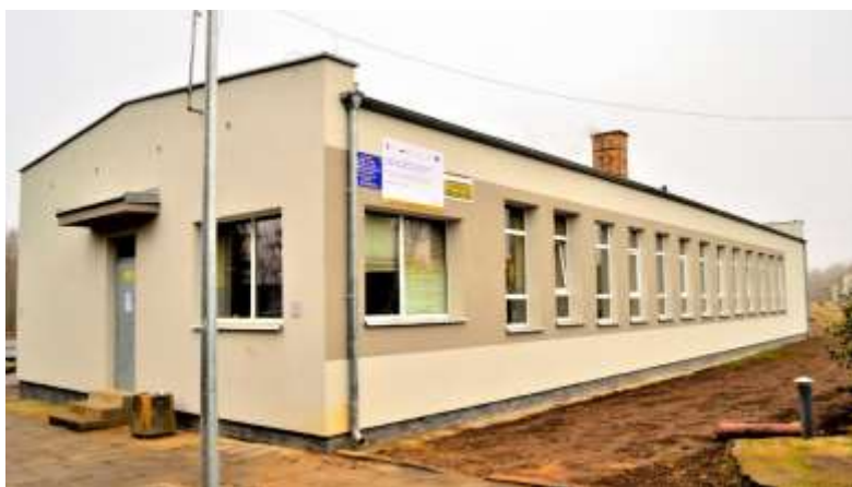
Fot. 1 Budynek Oczyszczalni Ścieków w Moryniu
