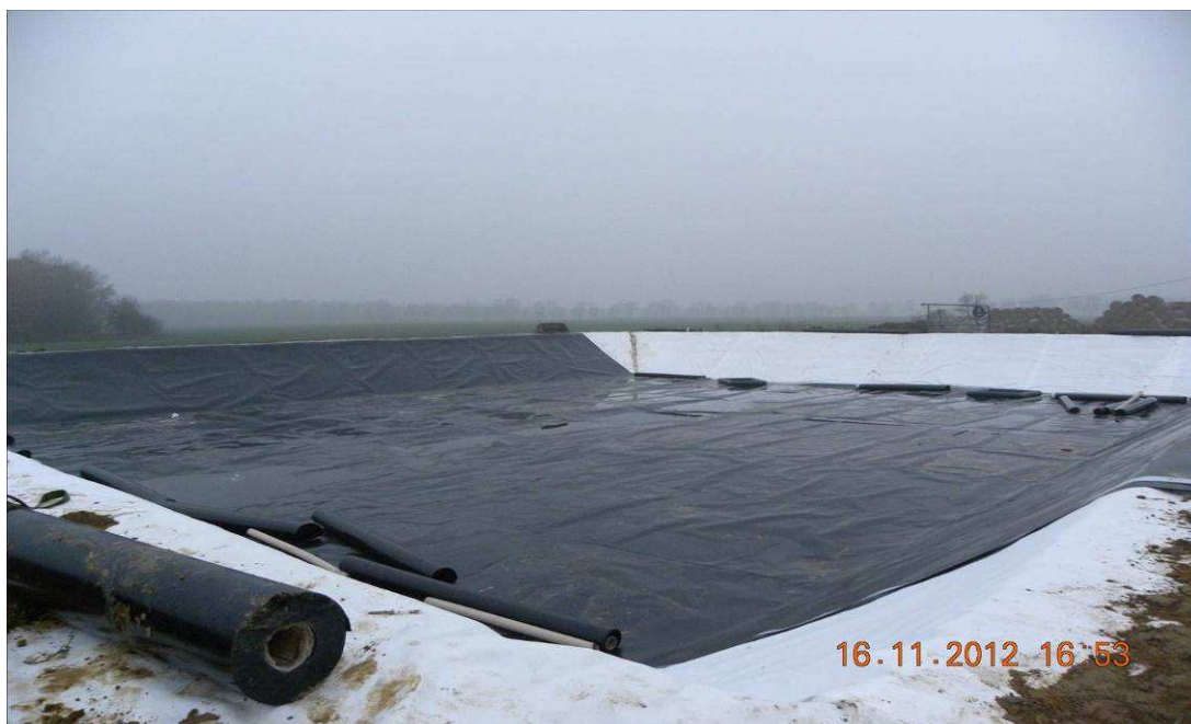
Fot. 6. Sposób układania warstw szczelnych zbiorników
