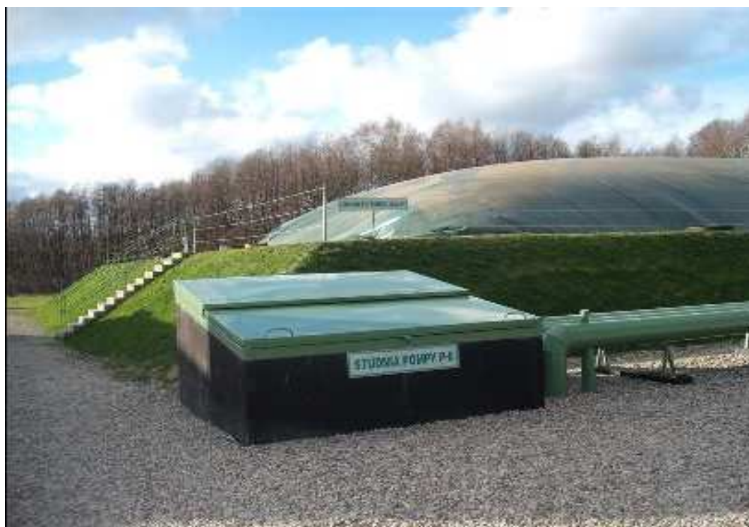
Fot. 8. Laguna ze szczelnym przykryciem wypełniona pofermentem
