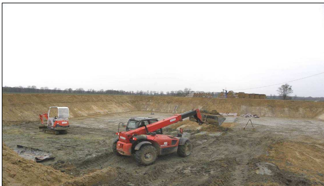
Fot. 4. Roboty ziemne przy wykopach i równaniu dna zbiornika - laguny
