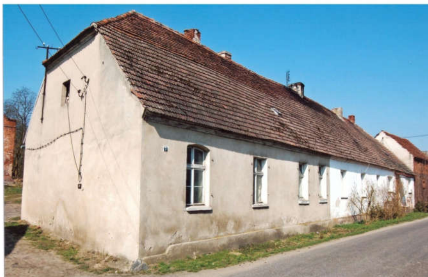
Gądko, ul. Moryńska 5, dom przed i po remoncie
