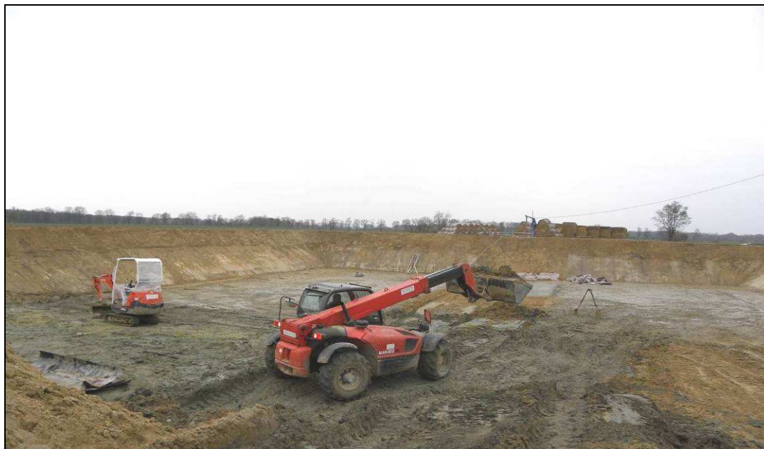
Fot. 5. Roboty ziemne przy wykopach i równaniu dna zbiornika - laguny
