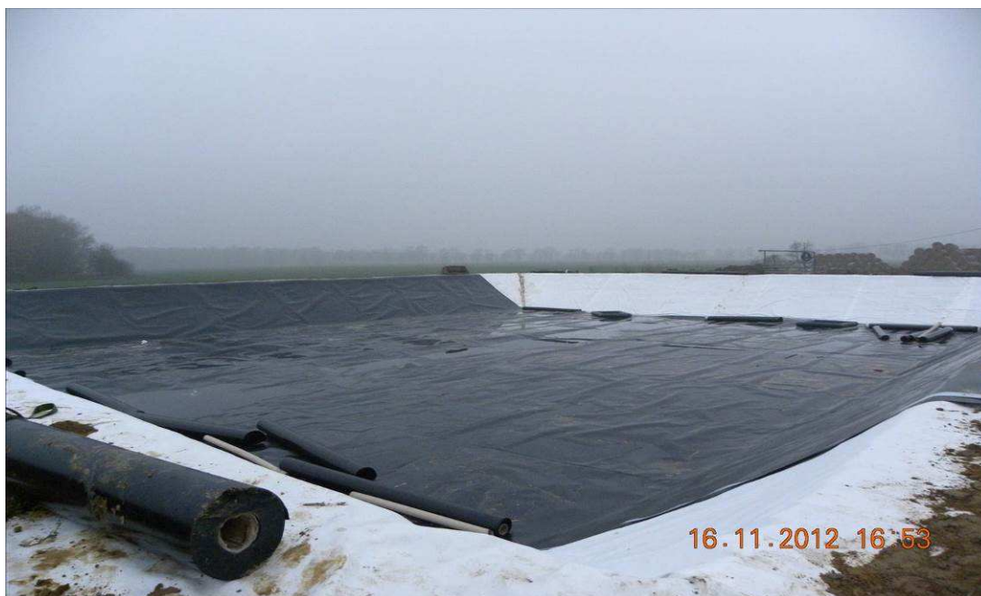
Fot. 7. Sposób układania warstw szczelnych zbiorników
