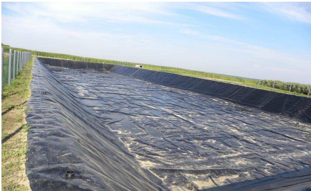
Fot. 6. Warstwy szczelne wyłożenia połączone zgrzewaniem lub spawem z pokryciem
